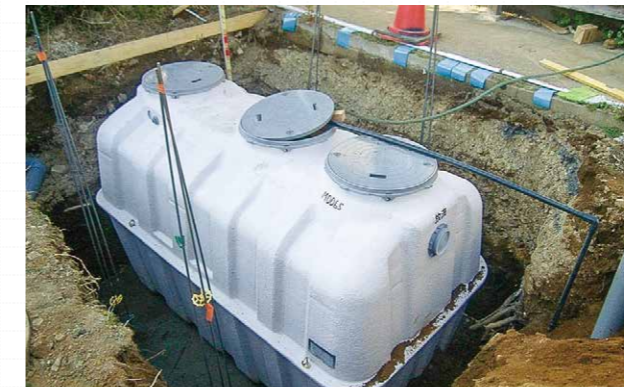
群馬県館林市での廃水処理ユニット施工現場
