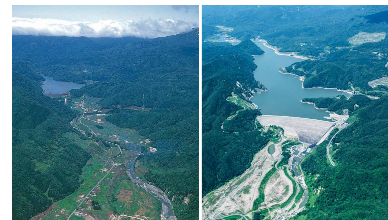
1953年に完成した石淵ダム(左)と、2013年に完成した胆沢ダム(右)。湖の大きさから総貯水量が格段に変わったことがわかります。(写真提供：胆沢ダム管理支所)
