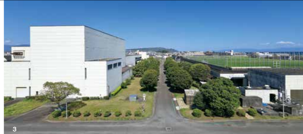
3. 中島浄化センターの下水処理施設。屋上部には人工芝の多目的スポーツグラウンドを設置しています 4. 2017年に完成した静岡県初の下水汚泥をエネルギー資源へリサイクルする汚泥燃料化施設
