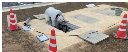
▲槽内のバルブ調整の様子
