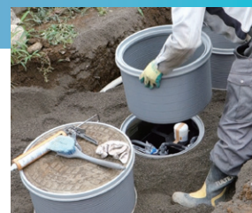
▲嵩上げ部材設置の様子
