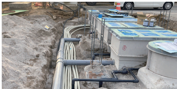
▲浄化槽二次側配管工事
