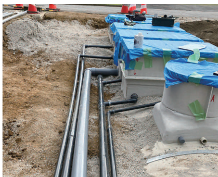
▲浄化槽周りの配管工事
