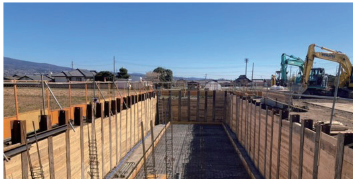
▲掘削後の様子(山留材使用)
