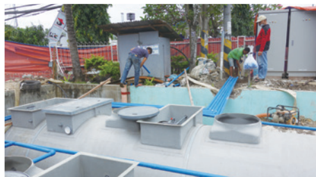
▲ フィリピンにおける大型浄化槽施工の様子
