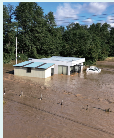
▲川の決壊により水没した郡山営業所の様子
