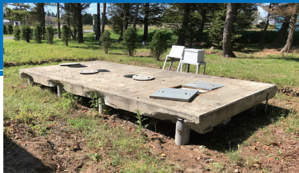
▲スラブが浮いた状態でも浄化槽本体は正常な機能を維持
