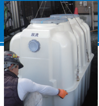
▲新設される合併浄化槽
