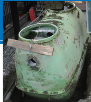
▲掘り出した単独浄化槽
