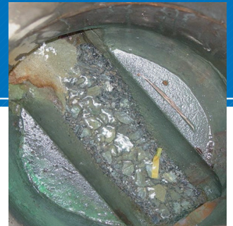
▲ 酸性排水で腐食したます
