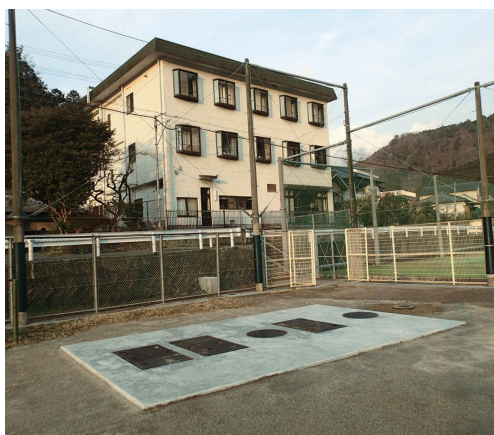
▲和歌山県の南部高校 龍神分校寄宿舎に施工された、フジクリーンの浄化槽(CEN型 35人槽)
