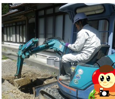
▲自ら掘削作業を行う川口さん
