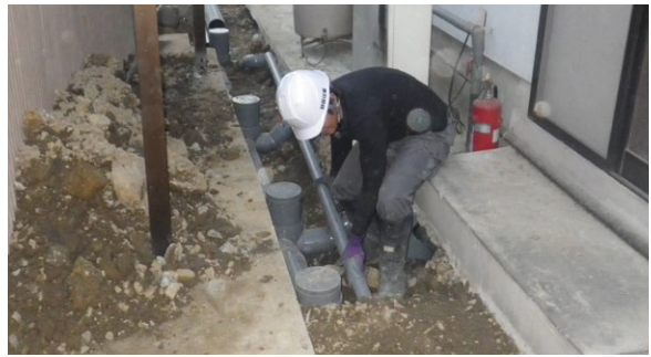
▲汚水配管の切り替え作業の様子
