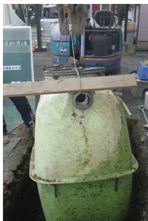
Before 掘り出した単独浄化槽
