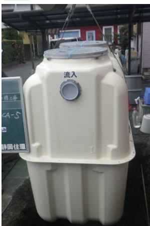
After 新設される合併浄化槽
