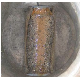
▲透析廃水により污水管が腐食し底部の骨材が露出
