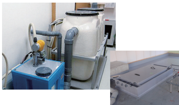
▲pH調整ユニットと、かさ上げ床下に格納できる中継ピット(オプション)
