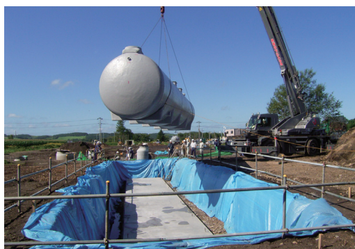
▲標茶町社会実験 FRP処理槽の搬入状況
