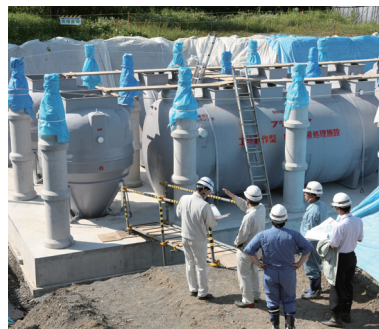
▲苫前町社会実験 現場での施工確認
