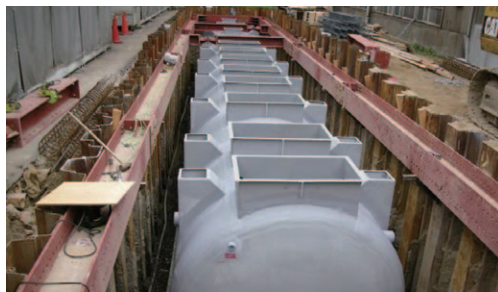
▲管体設置現場
