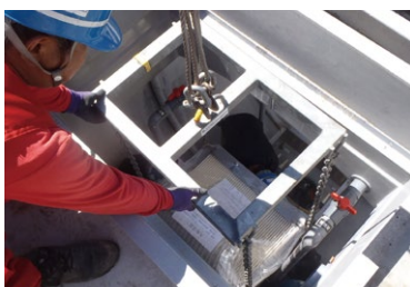
▲膜ユニット交換の様子
