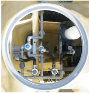
点検開口部 (写真: プロトタイプ)
