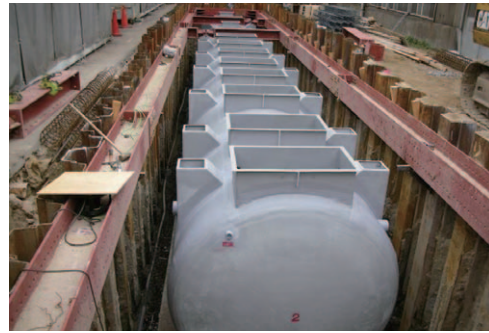
▲幅の狭い敷地に設置されたI型
