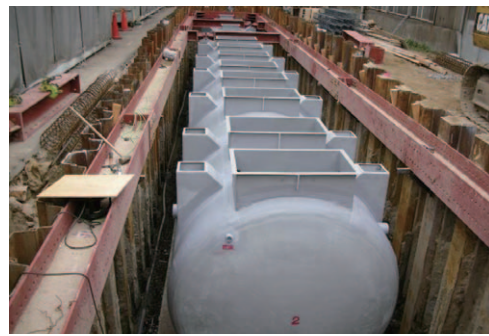
▲幅の狭い敷地に設置されたI型
