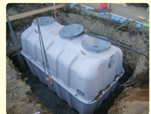
群馬県館林市施工現場(補助事業第一号)
