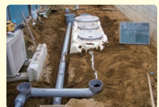
群馬県みどり市施工現場
