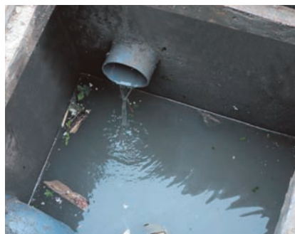
浄化槽への流入水は白濁し、固形物の混入も見られます。浄化槽が設置される前はこのような状態で放流されていましたが、浄化槽で処理されることで透視度50cm以上のきれいな水となっています。（写真左：流入水、右：放流水）
